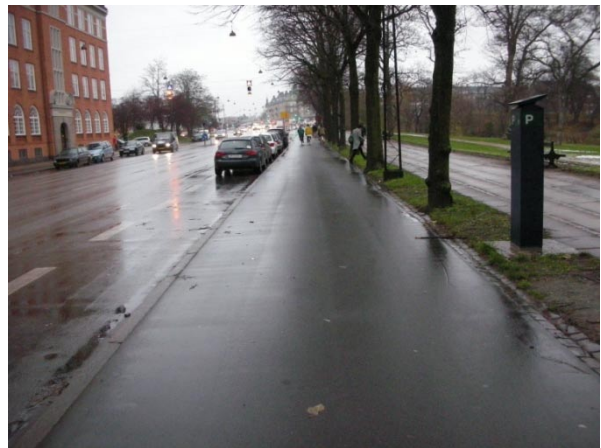
写真-2 コペンハーゲン都心部のCycle Track ・車道 路駐 Cycle Track 並木 歩道 ・質感・化粧のレベルが抜群 ・段差は3~5cm程度で、交差点でのすりつけがスムーズ
