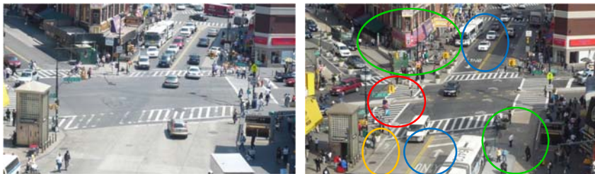
緑:歩道を舗装 青:車線を明確化+標識等設置 黄色:自転車レーン設置 赤:横断歩道を増設
