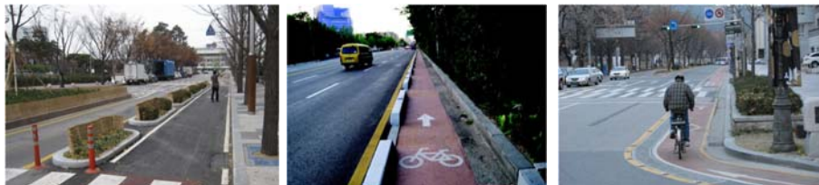
花壇分離 (韓国) 緑石ブロック分離 (韓国) 道路鋳+石分離 (韓国)
