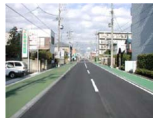
整備例：新川一丁目中原3号線 (カラー化等による車道部との分離明確化)
