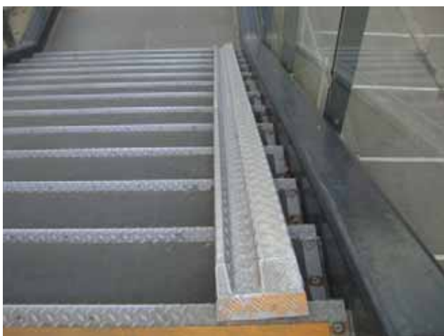
写真 1 4 駅の階段のスロープ
