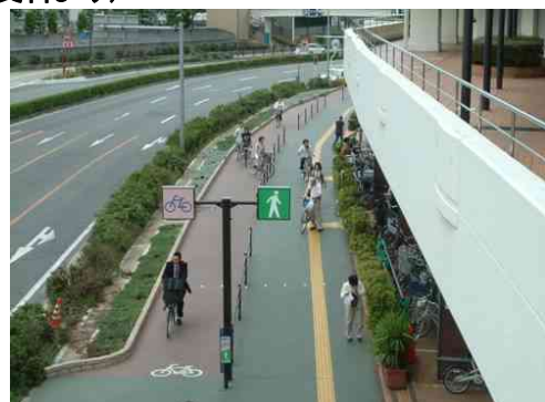
写真—2 分離柵設置後の状況
