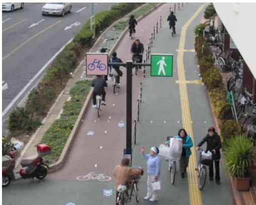
写真—4 中央線・マーク設置後の状況
