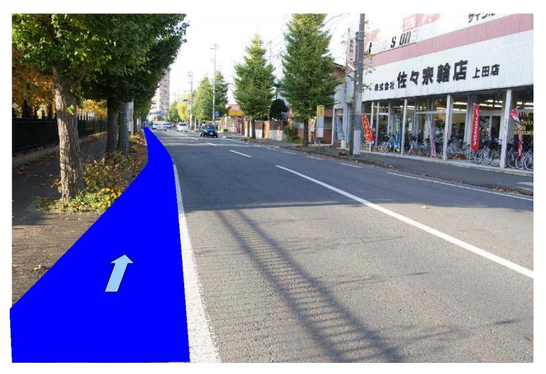
車道3.5m 自転車レーン 1.0m 側溝0.5m 歩道3.0m
