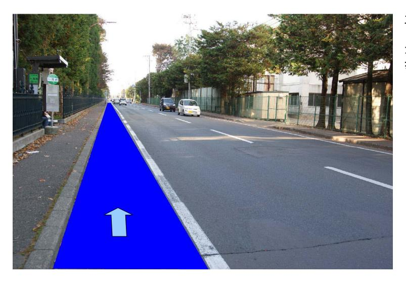
車道3.5m 自転車レーン 1.5m 歩道1.5m 岩大工学部側 フェンスを変更 視界を確保
